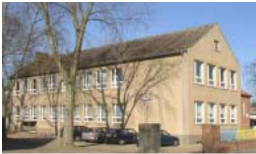
Die drei Klassenräume in der oberen Etage der neuen Schule sollen vorerst leer bleiben, um Heizkosten zu sparen.
