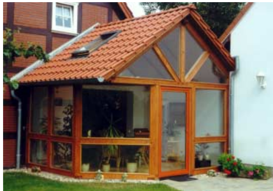
Der Wintergarten der Familie Sandau wurde von der Firma Wöllmann errichtet.
