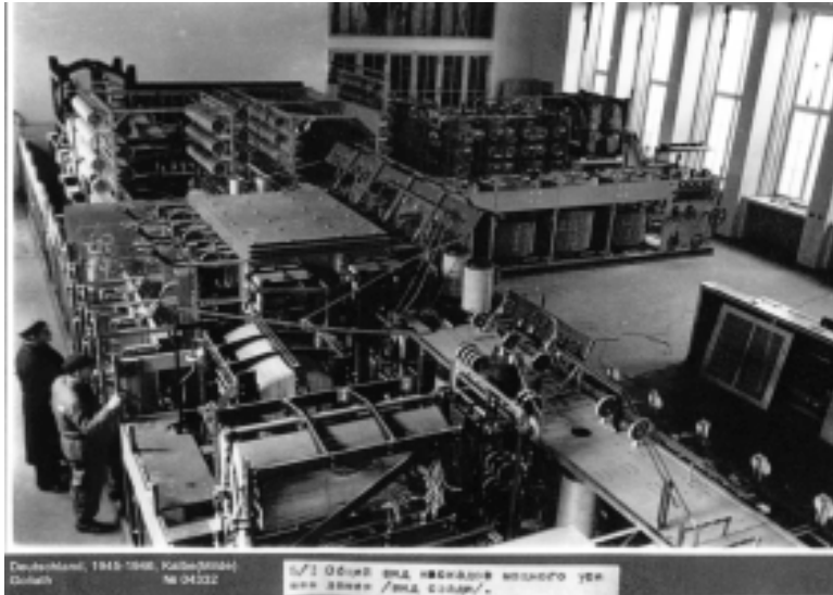
Eine russische Aufnahme des Senderraumes während der Demontage. Eine der Personen ist Dr. Gutzmann.
