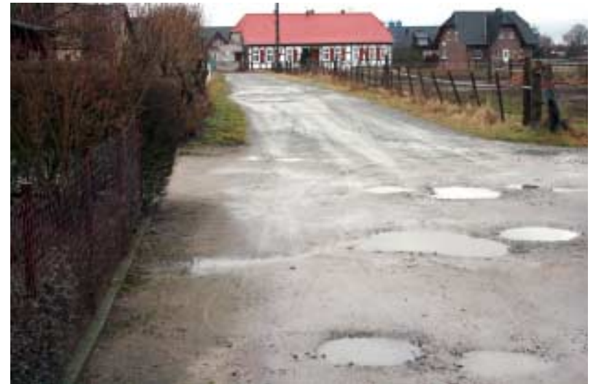
Diese Schlagloch- und Pfützenpiste am Schwarzen Weg möchte die Gemeinde gern beseitigen und eine günstige Verbindung zur Badeler Straße schaffen.
