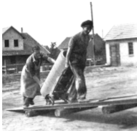
Transport von Betonteilen 1953
