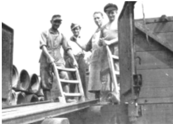
1953 werden Betonrohre verladen
