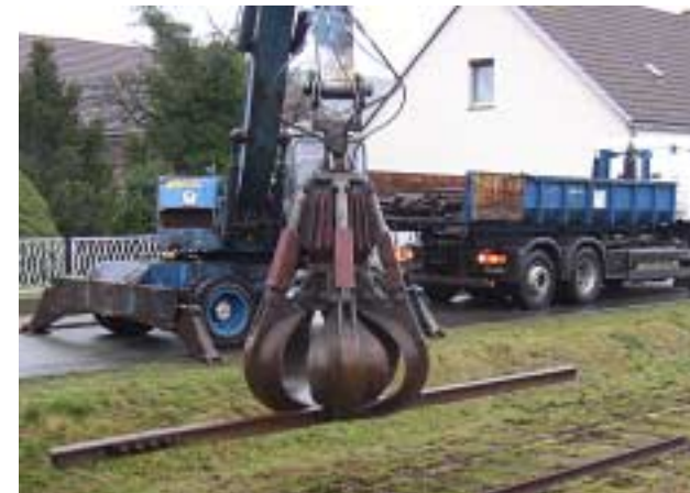
Abbau der Gleise in der Ortslage
