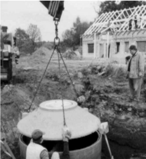
Eine Kleinkläranlage wird eingesetzt.
