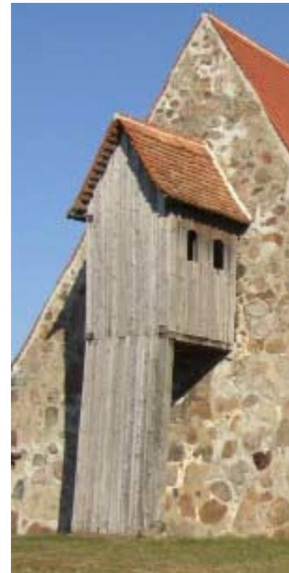
Am Westgiebel ist außen der Glockenstuhl als Holzkonstruktion angebaut. Diese Bauweise ist sonst in der Umgebung nicht zu finden. Das Glockenhäuschen hat Platz für zwei kleine Glocken. Da nur eine kleine Bronzeglocke von Zeit zu Zeit geläutet werden kann, bleibt die Frage nach dem Verbleib der anderen. Ältere Einwohner von Klein Apenburg erzählen, dass die zweite Glocke bereits im 1. Weltkrieg für Kriegszwecke verwendet wurde.
