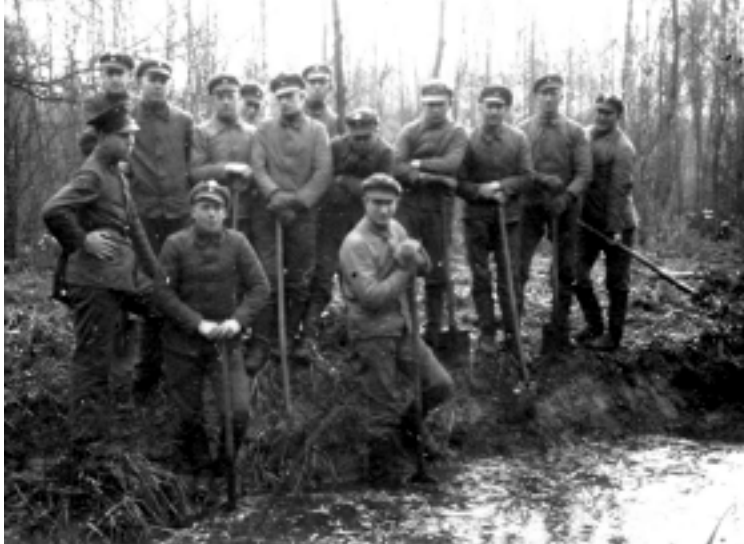
Auf der Baustelle des „Goliath“ mussten 300 Kriegsgefangene arbeiten. Hier russische Gefangene bei Ausschachtungsarbeiten.
