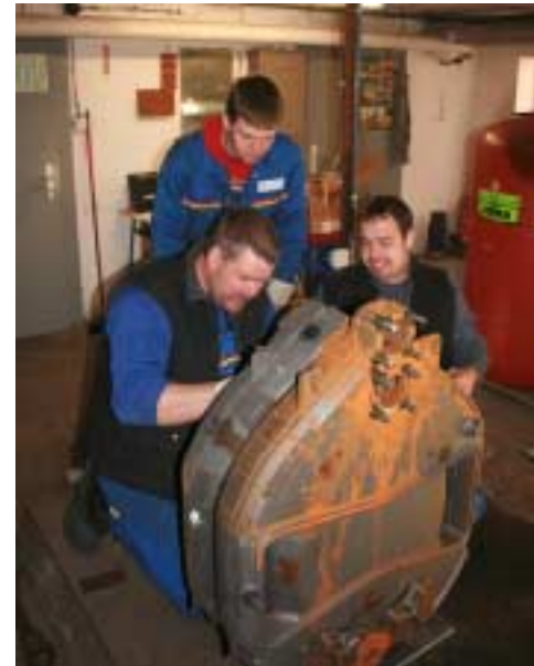
Einbau des neuen Kessels
