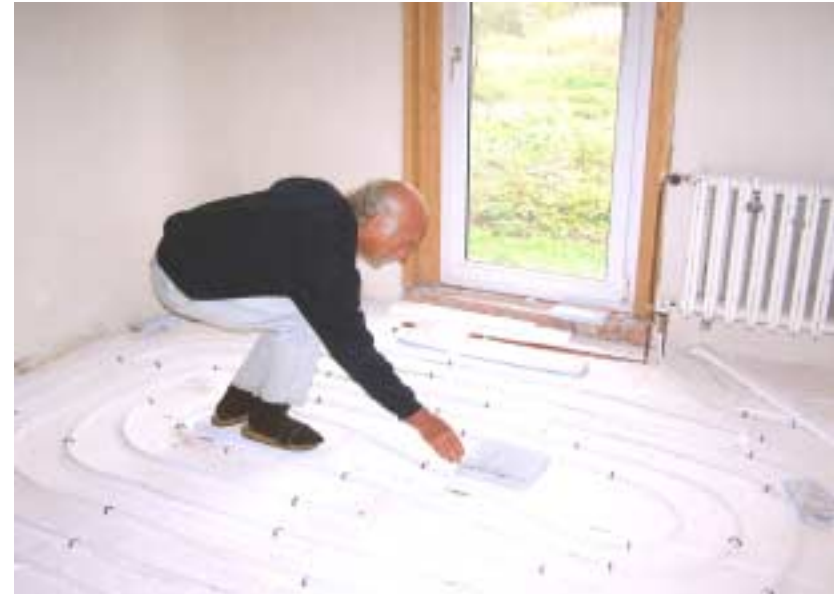
In den Wohnräumen wird von Chr. Lenz z.T. Fußbodenheizung verlegt.
