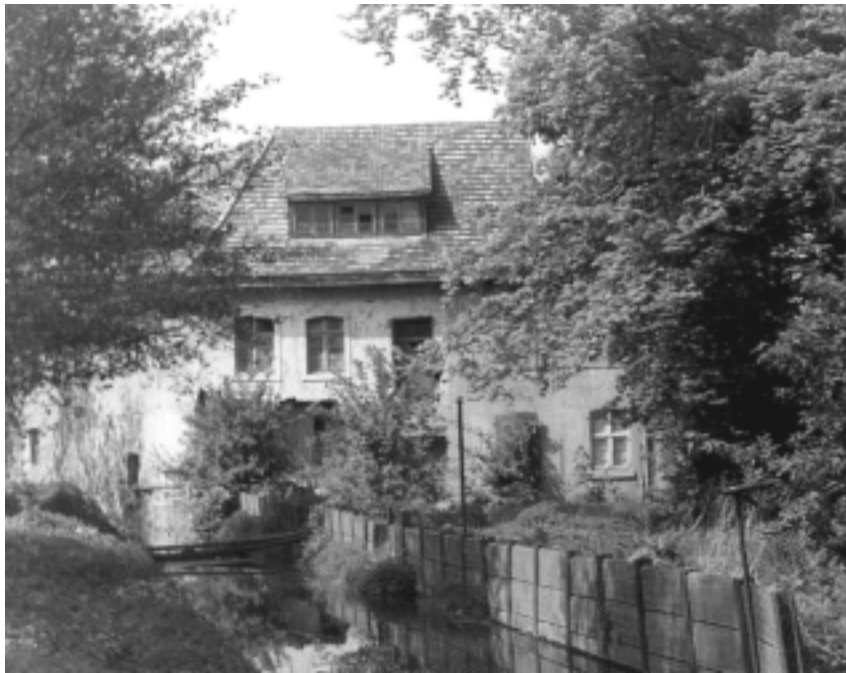
Die Neue Mühle nach dem Abbau des Fachwerkaufsatzes
