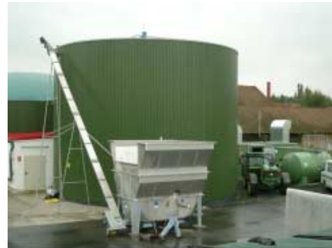
Teilansicht einer bestehenden Biogas-Anlage. (Quelle: Internet)
