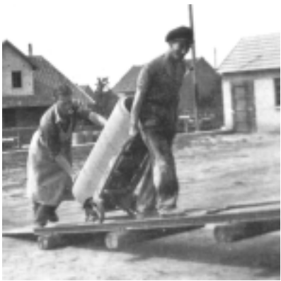
Betonrohre werden verladen
