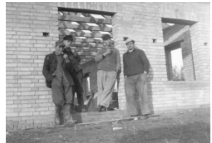
Richtfest der Halle 1 am 12.11.1954
