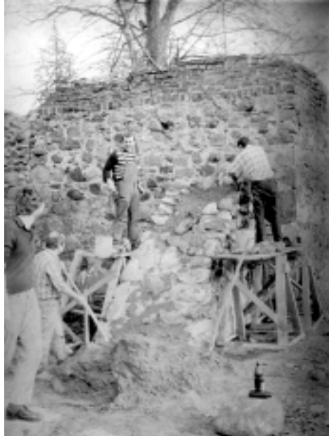
Bau des Stützpfelers
