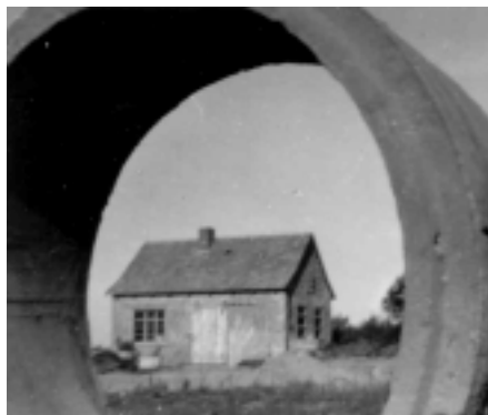
An der Abdeckerei wurden Rohre gestampft.
